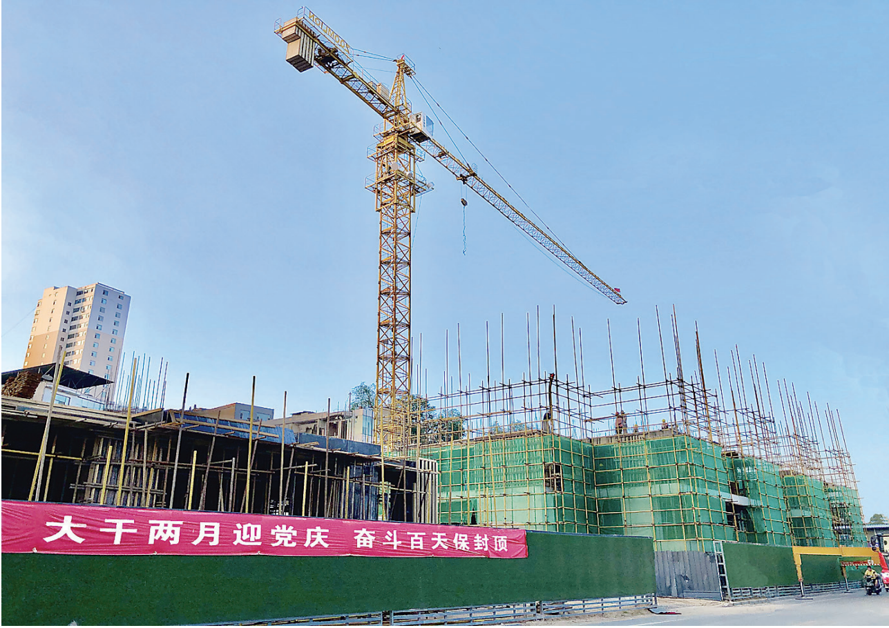
图为柳林县明清街在建项目在守好安全关、严把质量关的基础上,加快工程进度,确保各项目早日完工。 李璐 摄
