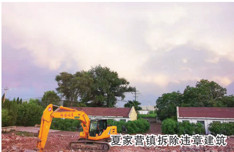
夏家营镇拆除违建建筑
