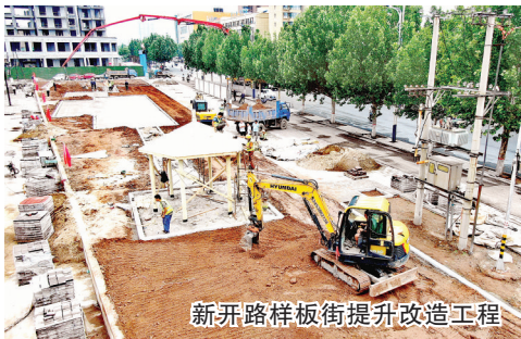
新开路样板街提升改造工程
