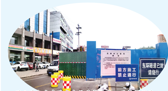
风山路与文丰路交汇处徐家沟路口开始封闭施工
