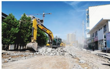
石楼县延安街东延建设项目是石楼县2021年政府工作报告中承诺的十件项目之一,道路全长3.37km,实施照明、监控、雨污分离、给排水、电力通信、供暖供气等管线入地,配套绿化美化设施,一次成型、一步到位,彻底解决周边群众出行不便难题。道路设计速度40-50km/h,标准横断面宽度为20米,路面采用4+6厘米沥青混凝土浇筑,人行道路面为6厘米人行道彩砖铺装。
