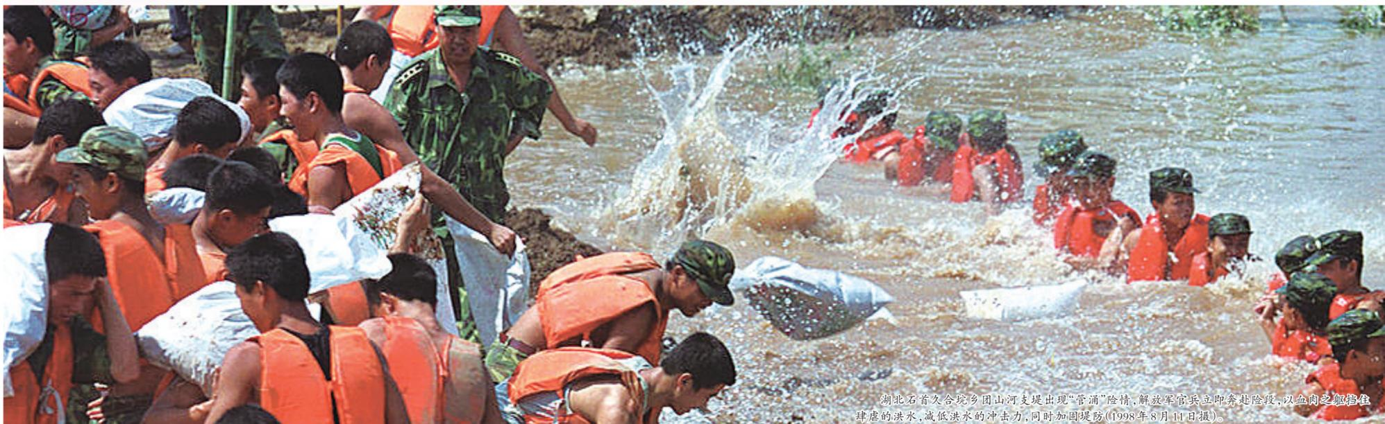
湖北省首义会垌乡团山河堤出现“管涌”险情,解放军官兵立即奔赴险段,以血肉之躯挡住肆虐的洪水,减低洪水的冲击力,同时加固堤防(1998年8月11日报)。
