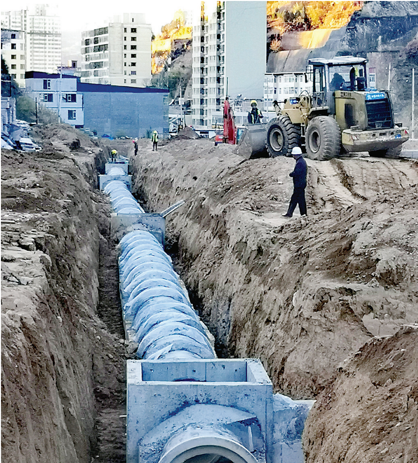
施工中的地下管道工程
