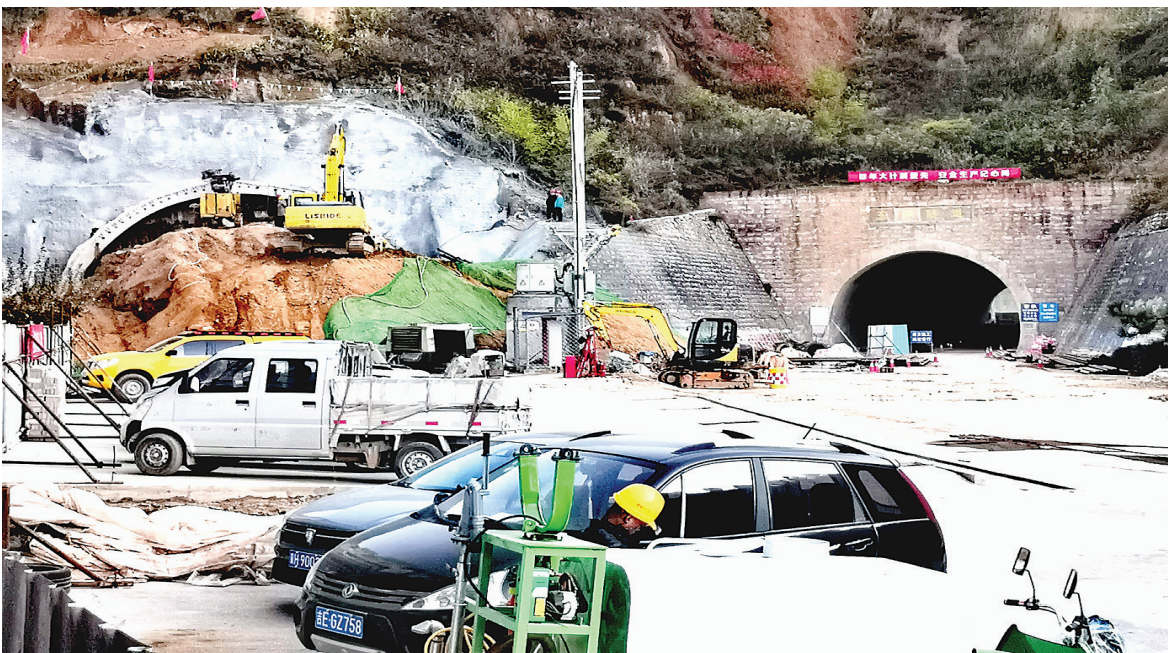
掘进中的隧道工程
