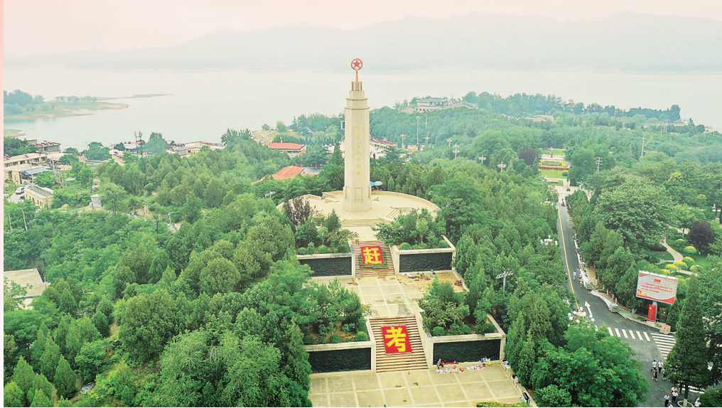
河北省平山县西柏坡纪念塔。
