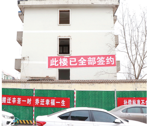
文丰路拓宽改造项目现场。吴旭军 摄
