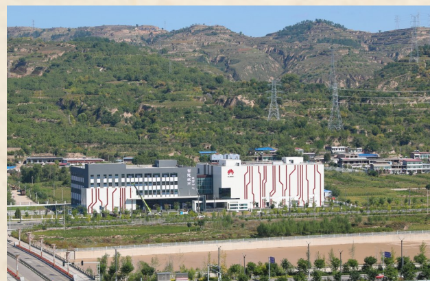
华为云数据中心
