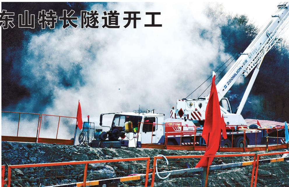
汾石高速公路东山隧道是目前吕梁第一长隧道,位于交口县与石楼县交界的灌林岩山,设计为分离式隧道,左洞长7730米,右洞长7810米。图为施工现场。
