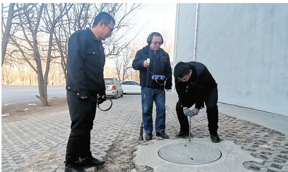
图为交城县供水公司工作人员正在对供水设施进行检修。
