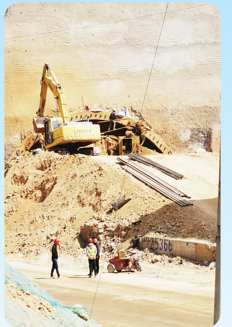
施工中的东环隧道
