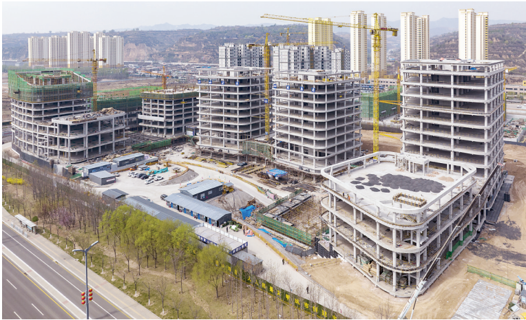
建筑面积11.2万平方米的吕梁双创中心项目位于吕梁新区,项目主要功能包括办公、人才公寓、酒店及配套商业。作为省重点项目,吕梁双创中心主体工程建设的已接近尾声,将于年内建成投用。 图为吕梁双创中心项目一角。
