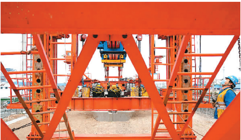
4月30日,山东省济南市黄台联络线施工现场,中铁十局的工作人员在进行双线箱梁架设作业。
