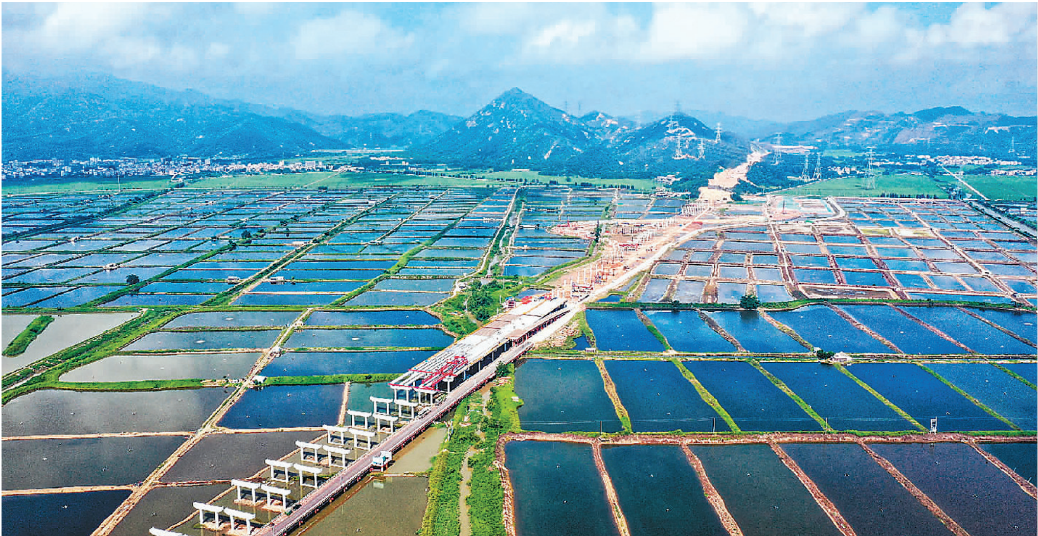
5月6日,广东省江门市黄茅海跨海通道建设现场。该通道建成通车后,将与港珠澳大桥、深中通道、南沙大桥、虎门大桥共同组成粤港澳大湾区跨海跨江通道群。
