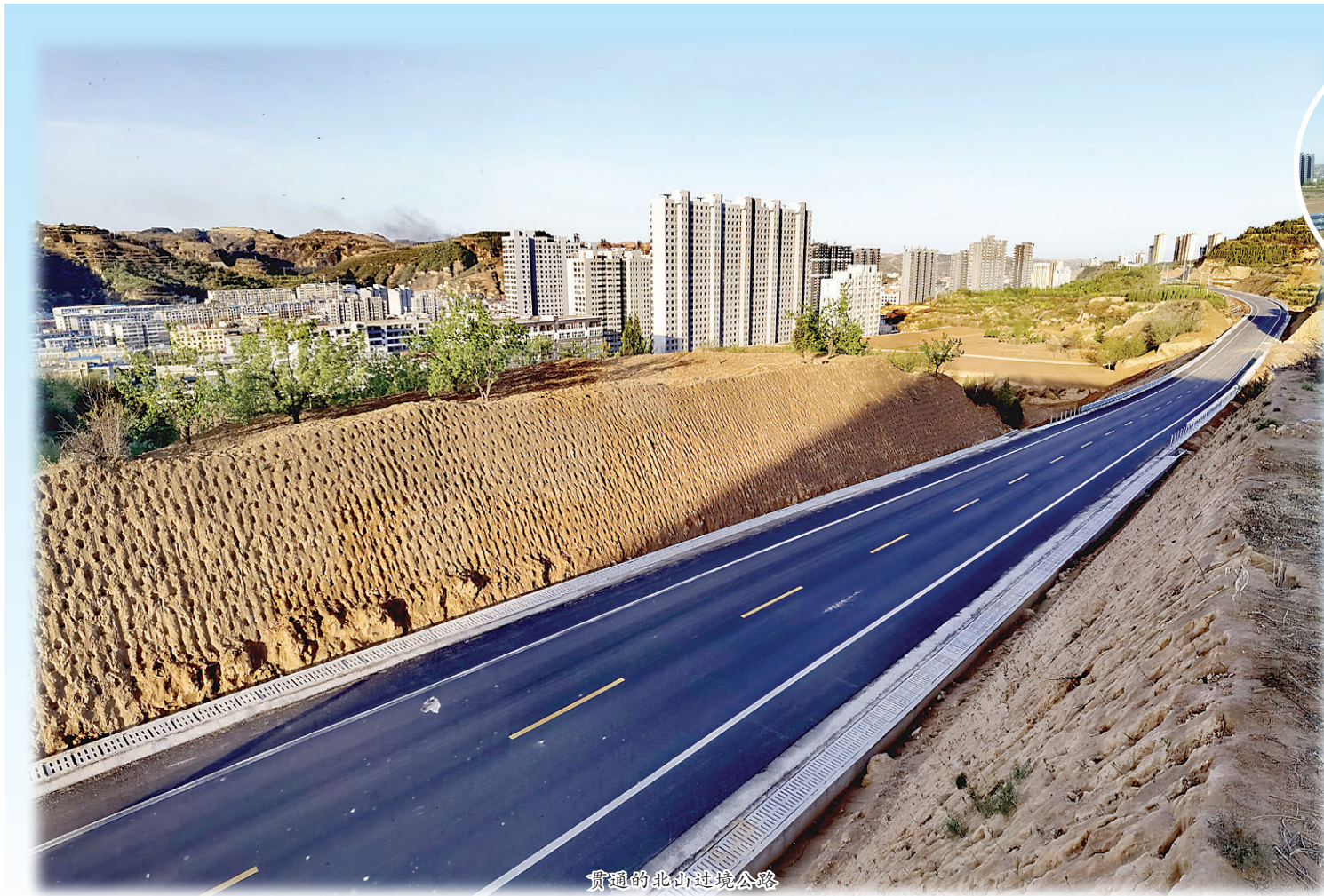
贯通的北山过境公路
