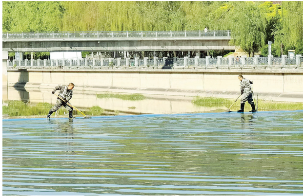
5月16日,市区北川河橡胶坝管理员在清洗坝面。
