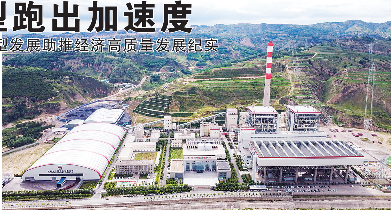
图为晋能大土河热电项目。
