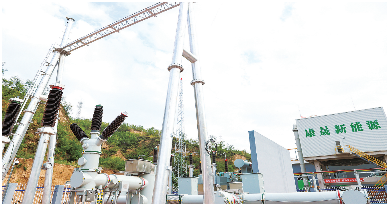
图为柳林县康晟新能源有限公司修建煤层气开发发电工程。
