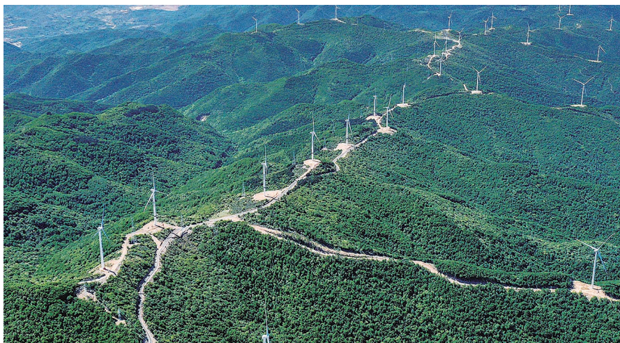
图为吕梁山上的风力发电机组。
