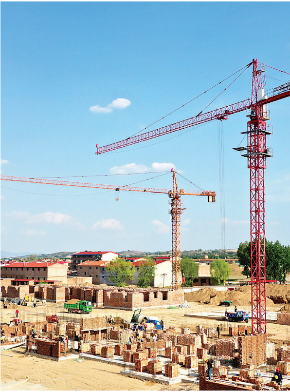
岚县利民小区公共租赁住房项目，规划建设1栋4层和5栋6层公租房，项目总建筑面积18748.09平方米，建成后可提供公租房302套，解决966人的住房问题。目前3栋已完成地基建设，准备主体开工，另外3栋已开挖基础，工程建设正在稳步推进中。
