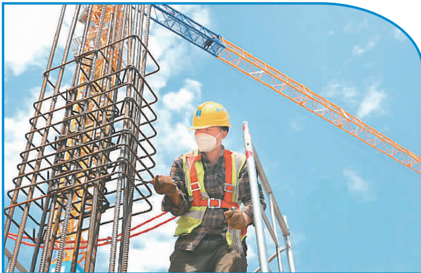
5月31日,建设者在位于上海浦东新区的西岛金融中心项目工地上工作。 新华社记者 方喆 摄
