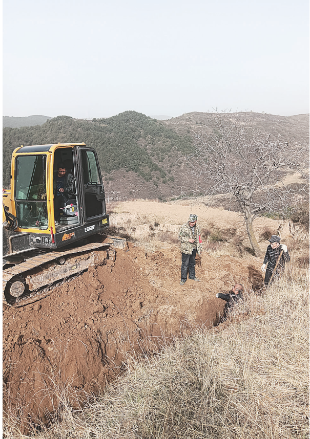
塔楼村杆树底组维修自来水管
