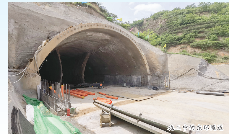
施工中的东环隧道
