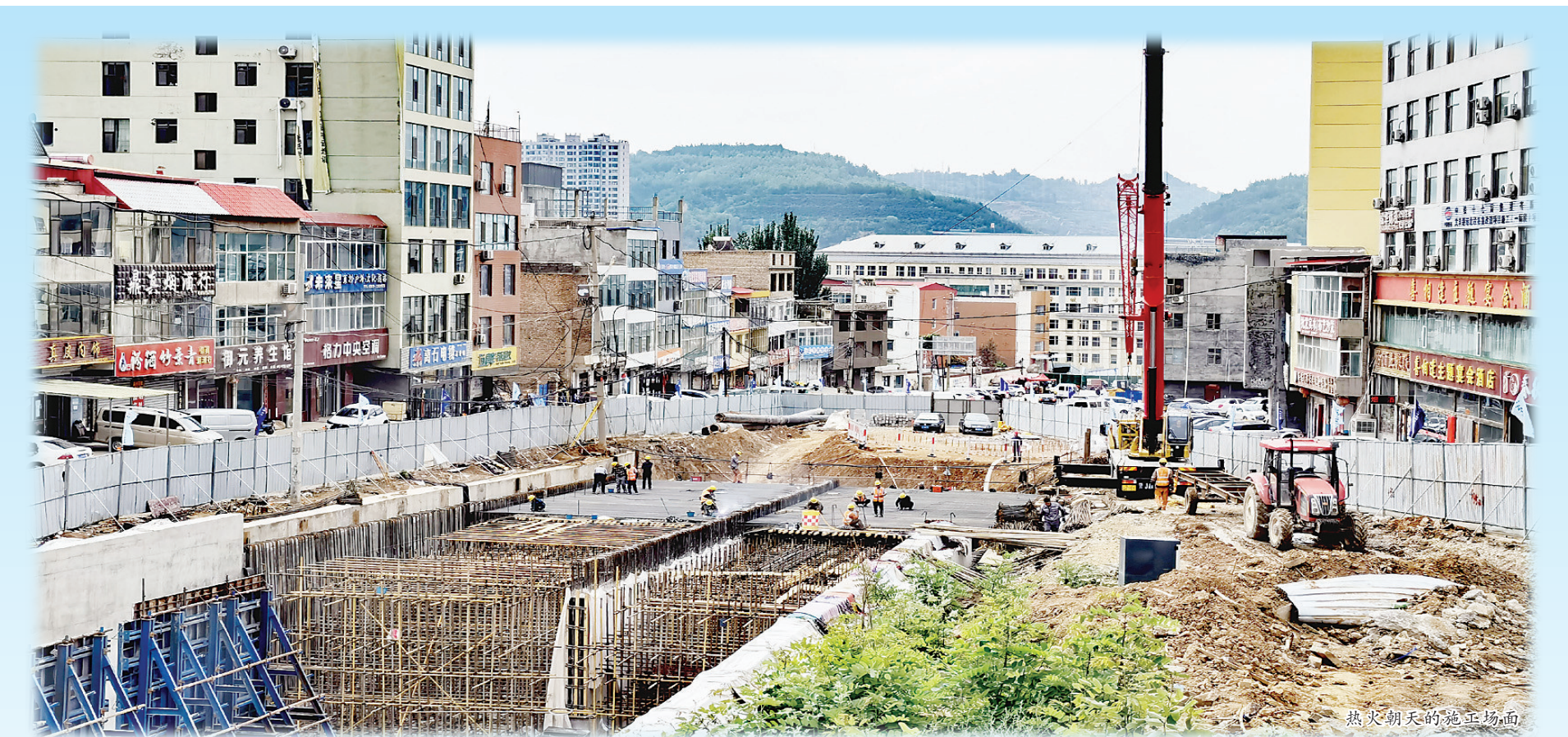
热天朝天的施工场面
