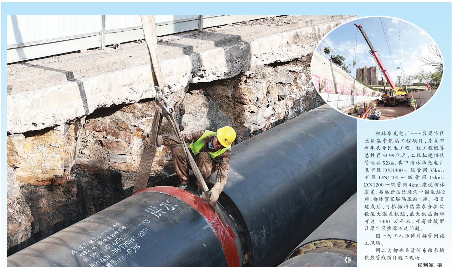
柳林华光电厂—吕梁市区长输集中供热工程项目,是我市今年头号民生工程。该工程概算总投资34.99亿元,工程拟建设供热管网共52km,其中柳林华光电厂至市区DN1400一级管网33km、市区DN1400一级管网15km、DN1200一级管网4km;建设柳林寨东、吕梁新区沙廉沟中继泵站2座,柳林贺家塔增压站1座。项目建成后,可根据用热需求分批投运大温差机组,最大供热面积可达3400万平方米,可有效缓解吕梁市区热源不足问题。
