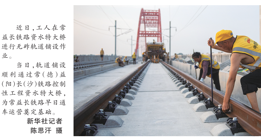
近日,工人在常益长铁路资水特大桥进行无砟轨道铺设作业。 当日,轨道铺设顺利通过常(德)益(阳)长(沙)铁路控制性工程资水特大桥,为常益长铁路早日通车运营奠定基础。 新华社记者 陈思汗 摄
