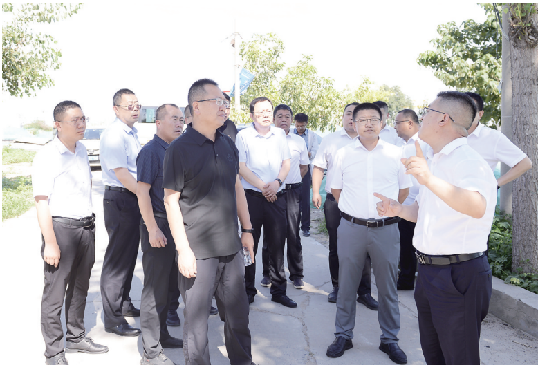
考察人员在河北省石家庄市藁城区中传宫灯大道项目建设现场实地了解情况。
