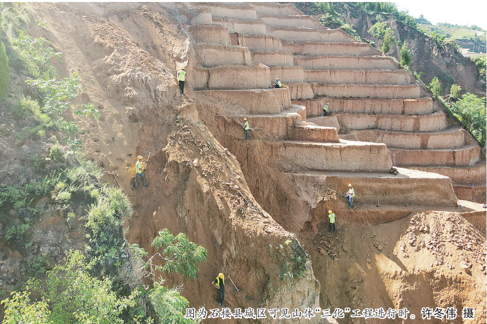
图为石楼县城区可见山体“三化”工程进行时。许冬伟 摄
