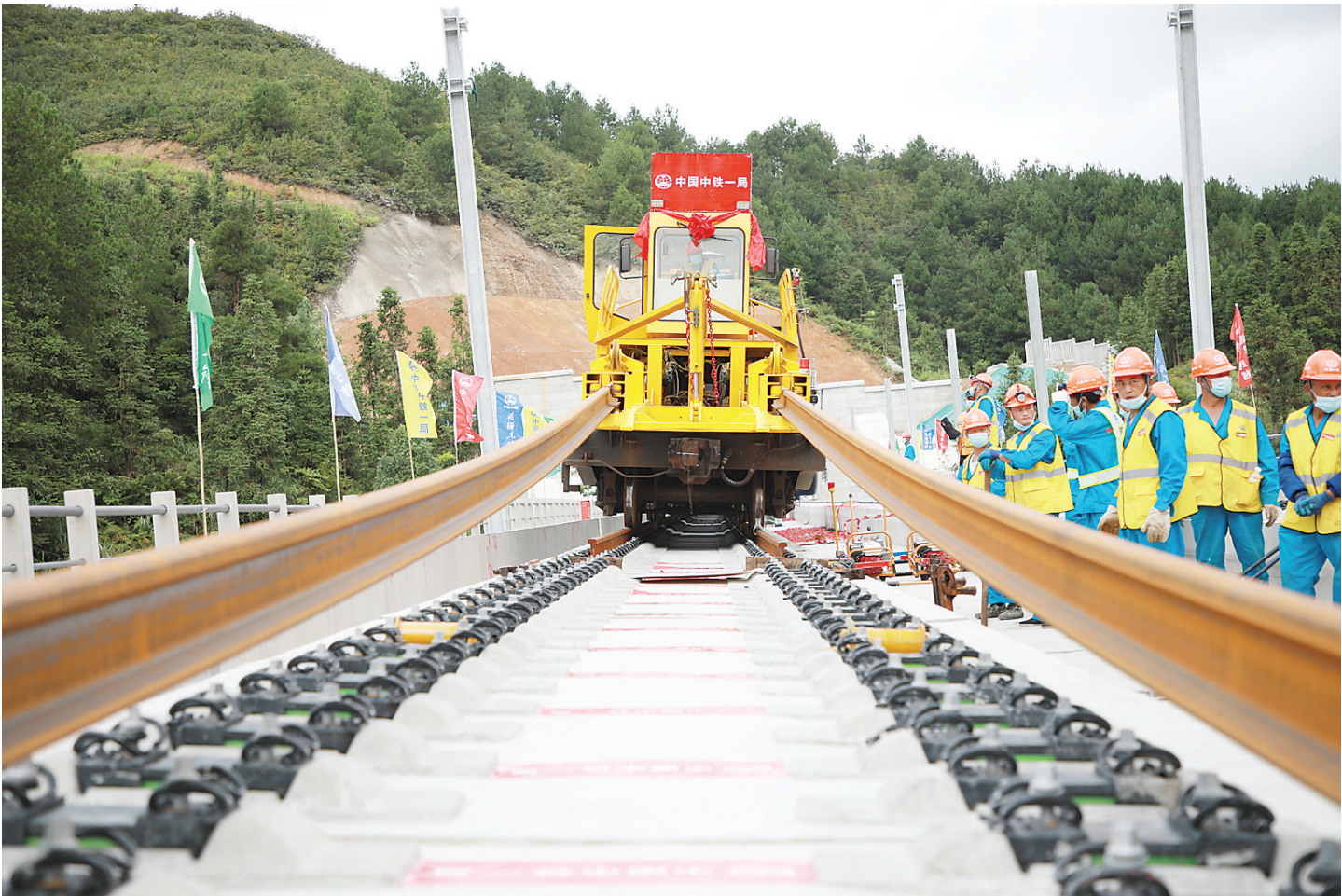
8月26日，中铁一局建设者们在进行铺轨施工。当日，随着一段500米长钢轨铺设在贵州省都匀市境内的新安双线大桥上，贵阳至南宁高速铁路贵州段进入全线铺轨阶段。贵南高铁是我国“八纵八横”高速铁路主通道包头至海口通道的重要组成部分，设计时速350公里。 新华社记者 刘续 摄
