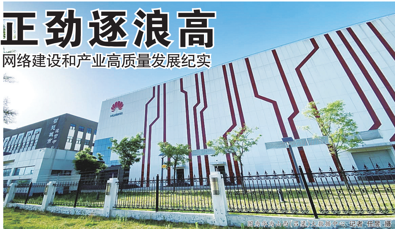
图为华为山西(吕梁)大数据中心。记者 任星 摄
