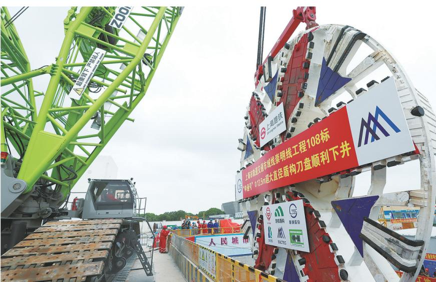
近日,一台履带式吊机在进行“申通号”盾构机刀盘吊装下井作业施工。在位于上海长兴岛的轨道交通崇明线108标施工现场,重达308吨的“申通号”盾构机刀盘吊装下井作业顺利完成。“申通号”盾构机将完成崇明线南越江段全长7.74千米的区间隧道掘进施工,这也将是上海轨道交通穿越长江的第一条隧道。新华社记者 方喆 摄
