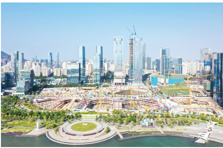
建设中的深圳湾文化广场(10月25日摄,无人机照片)。
