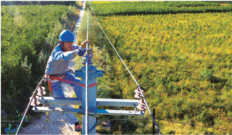
地电方山分公司职工正在维修线路。
