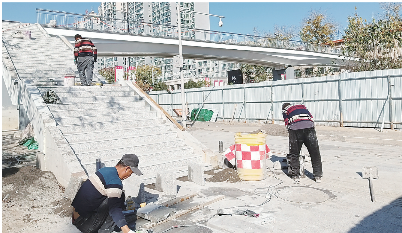
近日，笔者在汾阳市文峰路过街人行天桥施工现场看到，工人师傅正在紧张有序进行收尾工作，预示着汾阳市第三座过街人行天桥——玫瑰桥即将投入使用。
