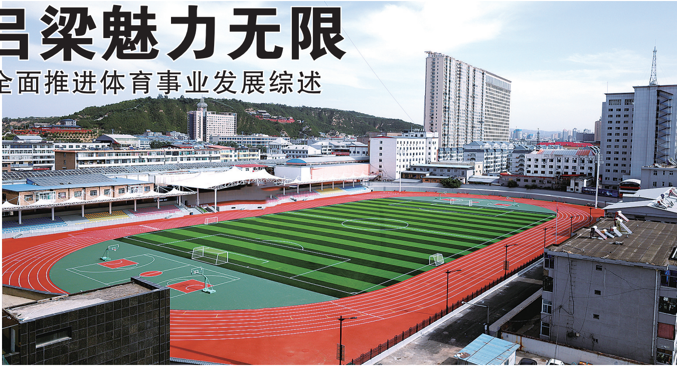
图为升级改造完成的吕梁市体育场。
