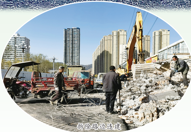
拆除路边违建
