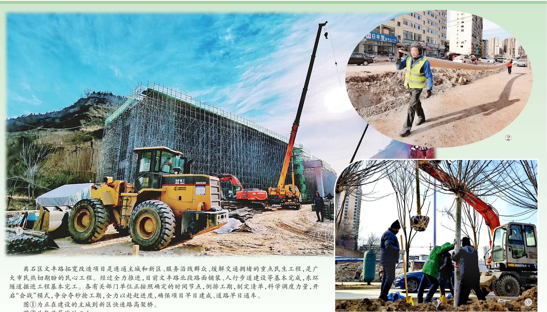
离石区文丰路拓宽改造施工项目是连通主城区和新区、服务沿线群众、缓解交通拥堵的重点民生工程,是广大市民热切期盼的民心工程。经过全力推进,目前文丰路北段路面铺装、人行步道建设等基本完成,东环隧道掘进工程基本完工。各有关单位正按照确定的时间节点,倒排工期,制定清单,科学调度力量,开启“会战”模式,争分夺秒抢工期,全力以赴赶进度,确保项目早日建成、道路早日通车。
