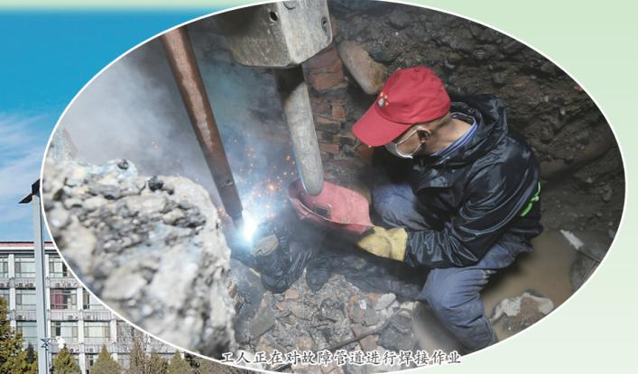
工人正在对故障管道进行焊操作
