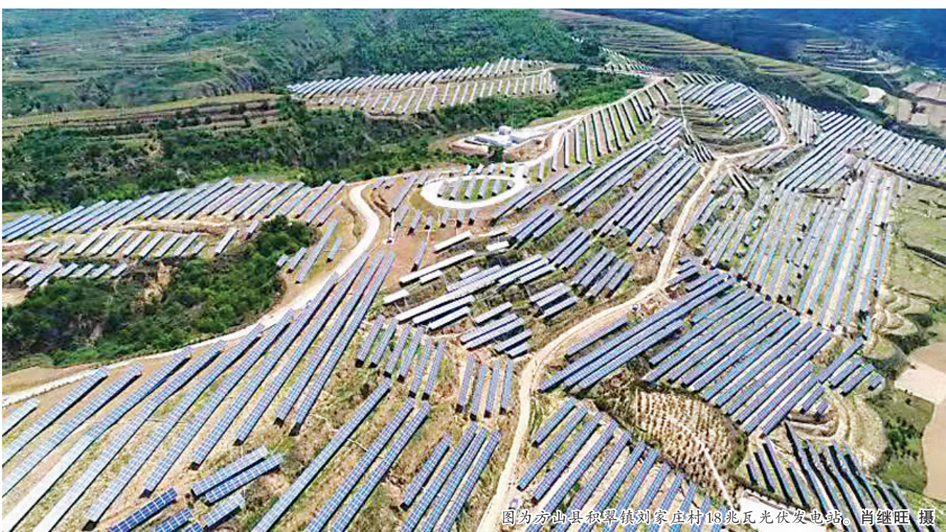
图为方山县积翠镇刘家庄村18兆瓦光伏电站。肖继旺 摄
