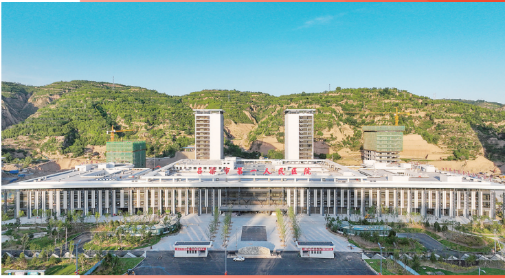
图为无人机拍摄的吕梁市医疗卫生园区项目一角。
