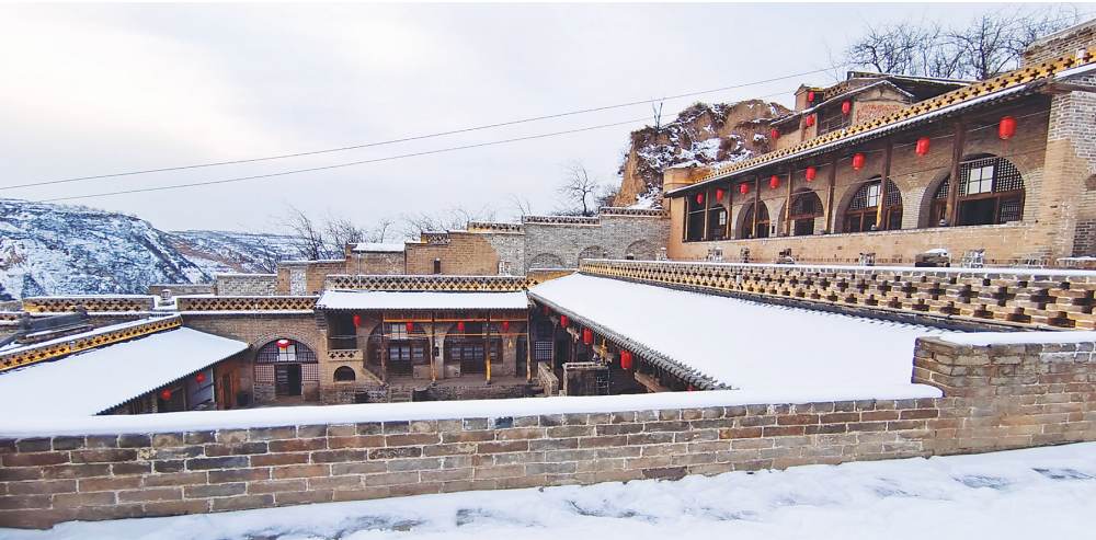
梁顶六院下三院
