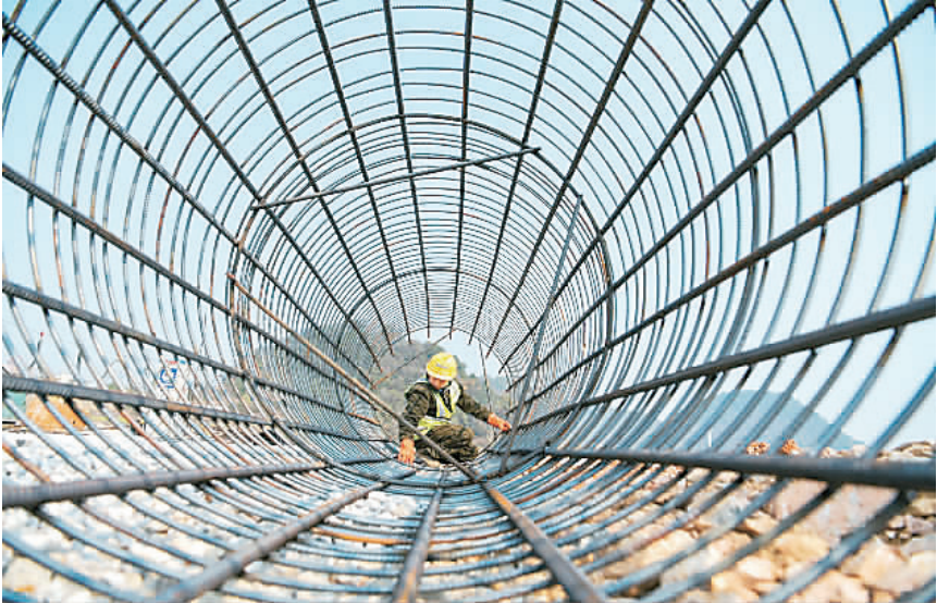
2月1日,贵州省2023年一季度重大项目集中开工,图为工人在贵安新区美的云一期土建总承包工程项目现场施工。
