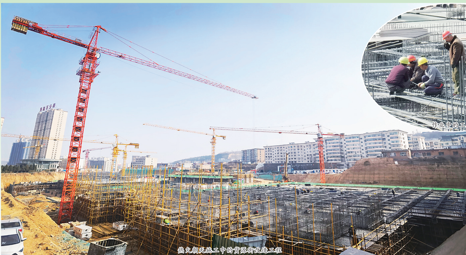
华鲁钢铁施工的华鲁街改造工程
