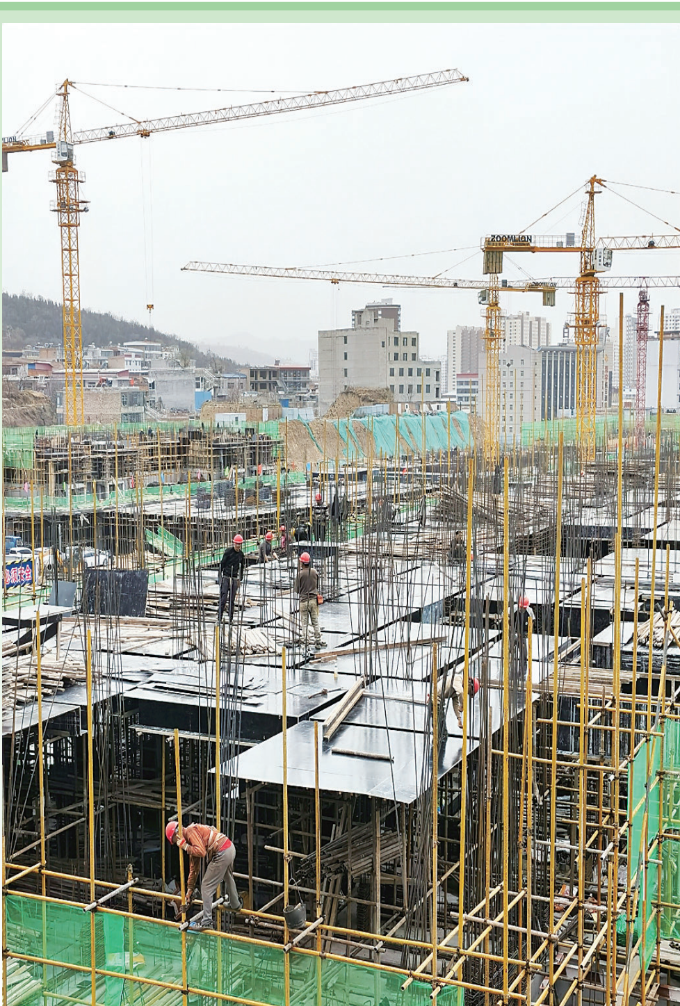
货源街提升改造工程作为市区城市建设重点项目之一，连日来，相关管理部门及承载企业抢抓项目建设黄金期，切实增强抓项目建设的责任感、紧迫感，科学安排施工，全力以赴推进各项任务落实，确保按时完成重点项目建设任务。货源街提升改造工程完工后，既有助于改善城市人居环境，为群众提供一个休闲、娱乐、健身的好去处，又能进一步提升群众的获得感、幸福感和满意度，助力打造美丽幸福吕梁。记者 郭炳中 摄
