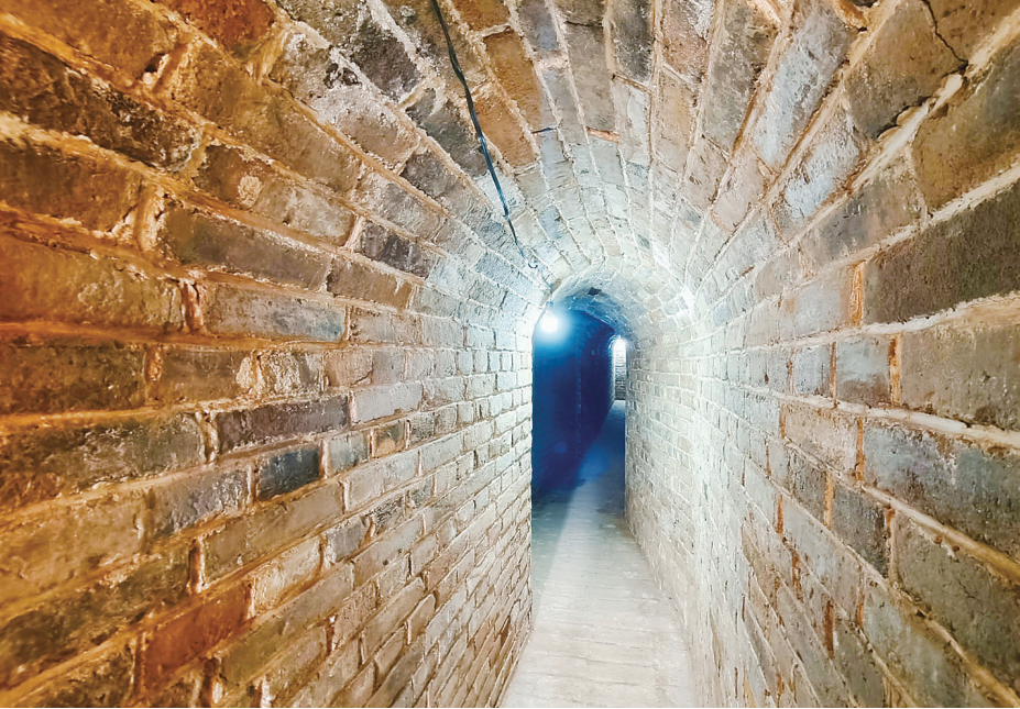
地下甬道一角
