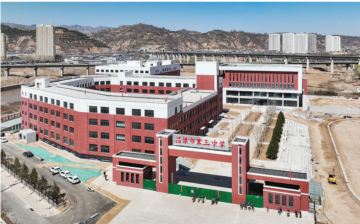
吕梁市第三初级中学项目选址位于吕梁新区离石区西属巴街道霜雾都村,占地面积约57亩,总建筑面积约3.3万平方米(包括教学楼、实验楼、图书馆、宿舍楼等),总投资约2.1亿元。该项目是市委、市政府深入贯彻教育优先发展战略,着眼于解决制约吕梁市区教育高质量发展瓶颈,满足老百姓对高质量公办教育的需求,在新城区规划修建的重点民生工程。项目建成后可容纳1800名学生就读。
