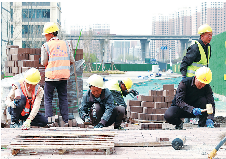
连日来，吕梁新区各项目工地机器轰鸣、塔吊运转，一线工人全力以赴加快重点工程施工进度，确保如期完工。
