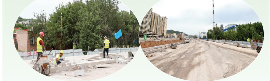
近年来,我市高度重视中心城区建设发展,合理布局规划。市区呈祥路南延(碧水路一交口商业街)工程是我市重点民生工程之一。该工程建设北起碧水路桥,沿三川河东岸向南上跨污水处理厂延伸至交口商业街,全长1936.337m,其中桥梁长度510.62m,路面按城市次干道设计,设计速度30km/h。该工程碧水路至龙运大街段道路红线宽20m,为双向两车道,龙运大街至交口商业街段道路红线宽30m,为双向四车道。该项目建设包括:道路、桥梁、排水、给水、箱涵、照明、绿化等工程。项目的建成投入将有效缓解龙凤南大街交通压力,有力改善市民交通出行环境。侯利军 摄
