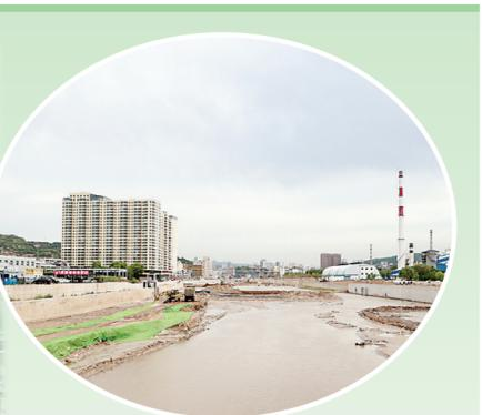
图为正在改造建设中的市区北川河一号坝至交口大桥河道整治工程(黑臭水体治理项目)。该工程主要解决该河段生活污水直排河道,水体黑臭等水环境质量差及河道淤积,行洪能力不足,防洪标准不达标等突出问题。治理范围为北川河一号坝至交口大桥,治理长度4.32km,区间有枣林沟、刘家湾沟和南川河汇入,总投资2.25亿元。建设主要为河槽清淤、河道右岸堤防建设、截污排污及箱涵闸门、河道左岸加高堤防、沟道排进口、蓄水拦河坝5座、人行步道、绿化等工程。通过修建复式河道,满足防洪要求,运用截污、清淤、修复等手段,使黑臭水体总体得到控制,恢复径流过程的良性循环,呈现出“水清、岸绿、景美”的良好环境,改善生态。
