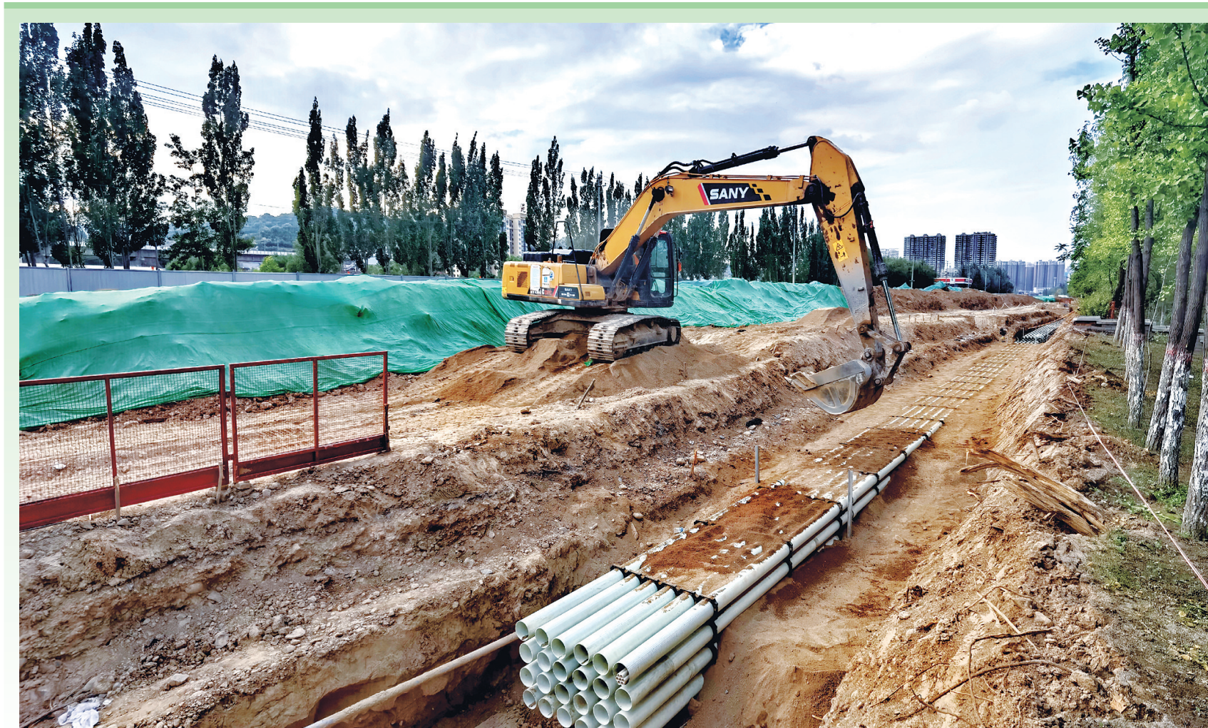
连日来,吕梁市临安路升级改造为新安大道道路提升改造项目如火如荼,各路段全力以赴,多个作业面同步施工,以最严标准、最严管理、最严操作推进工程进度,切实提高道路通行效率,推动城市建设高质量发展。 记者 郭炳中 摄
