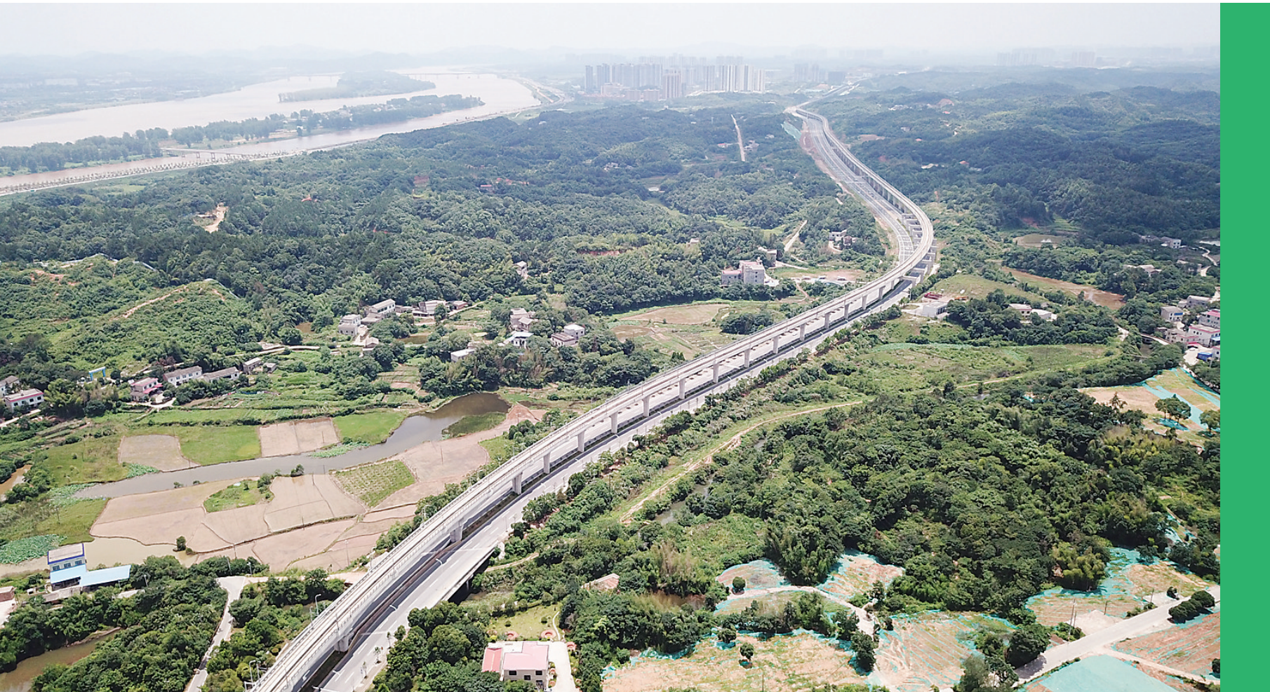
这是6月28日拍摄的长株潭城际轨道交通西环线一期工程的高架轨道（无人机照片）。
